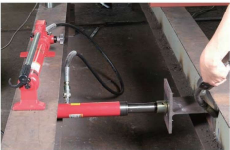
●鋼材等の溶接後、歪み取り作業
